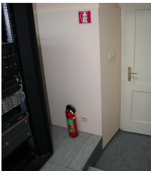
Sl. 20. Aparat za gašenje požara Fe36 na ulazu u serversku sobu s južne strane [14]
