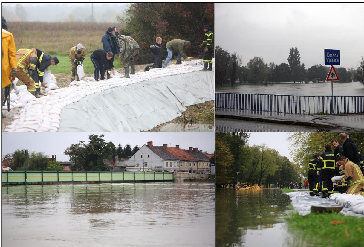
Sl. 20. Gradnja zečjih nasipa [18]
