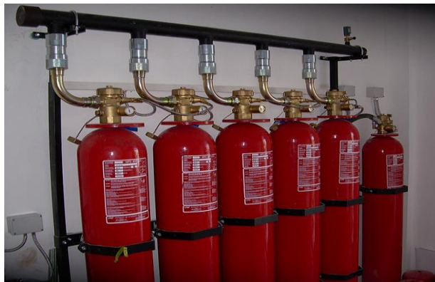
Slika 11. Sistemi za gašenje plinom Novec 1230
