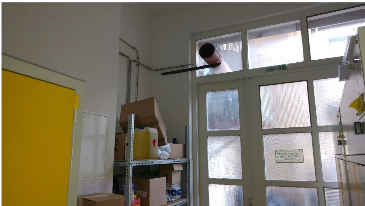
Slika 6: Predodžba prostorije s neadekvatnom ventilacijom: Izvor autora
