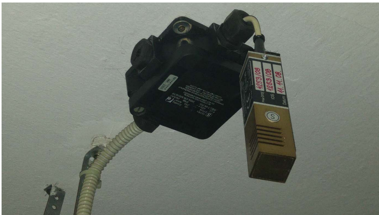
Slika 19: Predodžba plinodojavnog detektora tzv. “njuškalo“: Izvor autora
