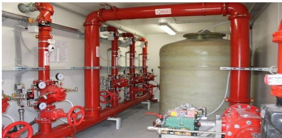
Slika 8. Sprinkler stanica [14]
