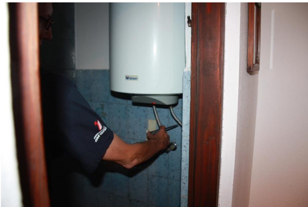
Slika 32: Ispitivanje električnih uređaja (uređaj za zagrijavanje vode) [20].
