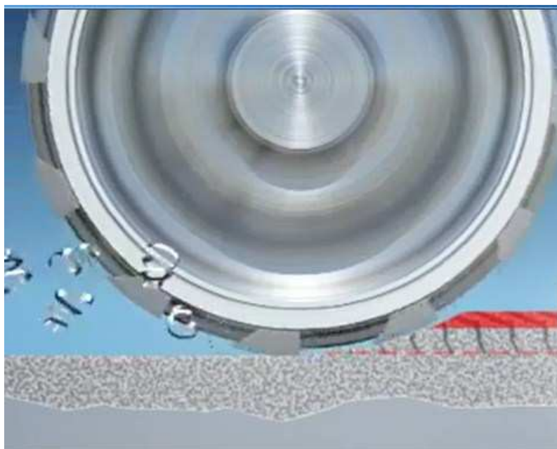
Slika 21. Obrada gornje površine tračnica klasičnim brušenjem [15]
