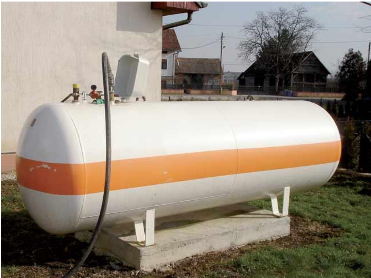
Slika 9. Mali nadzemni spremnik za domaćinstvo[9]
