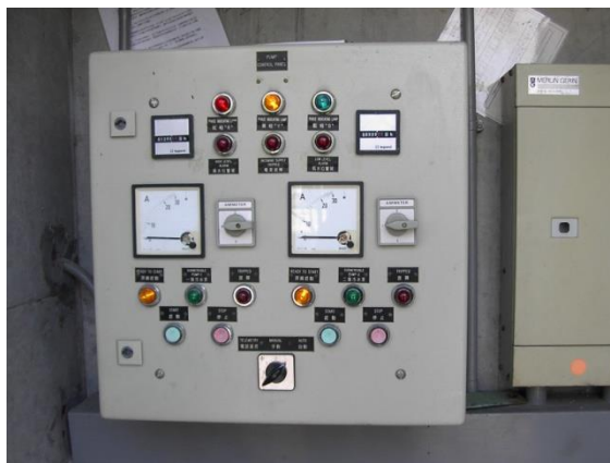
Slika 79. Primjer upotrebe LED indikatora
