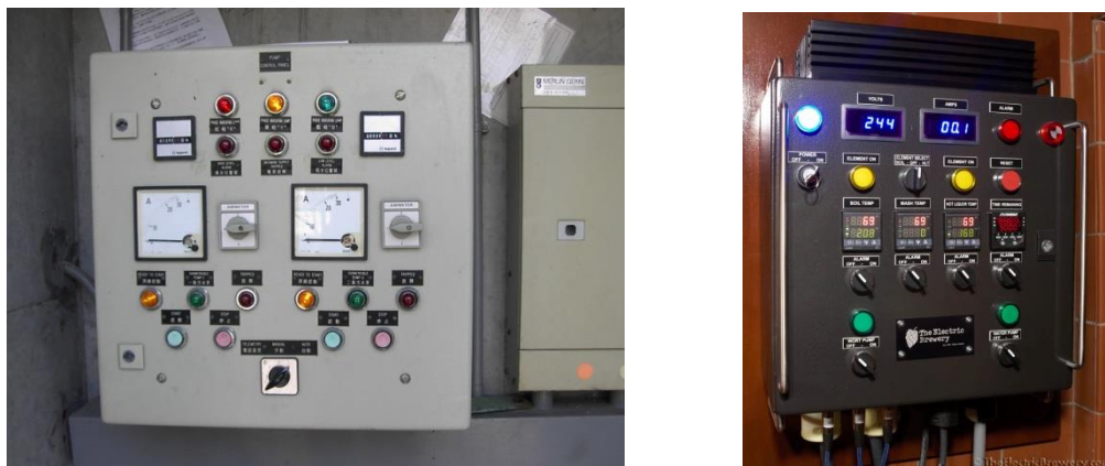
Slika 79. Primjer upotrebe LED indikatora
