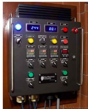
Slika 79. Primjer upotrebe LED indikatora
