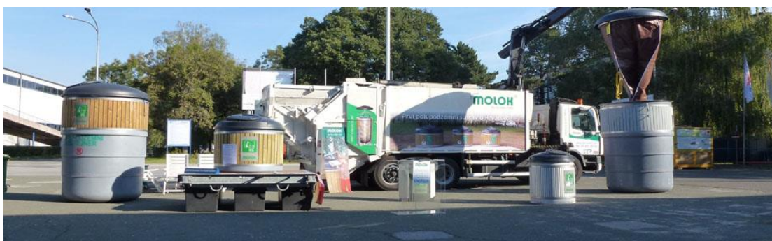
Slika 5. Postavljanje MOLOK polu-podzemnih kontejnera
