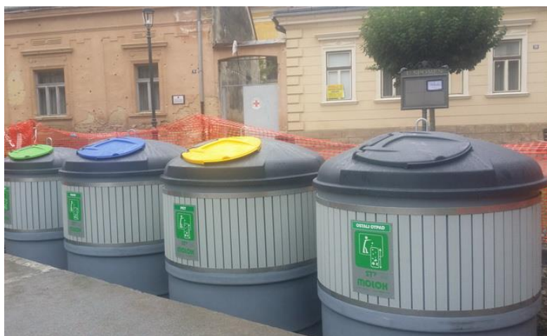
Slika 4. Daruvar – MOLOK polu-podzemni kontejneri
