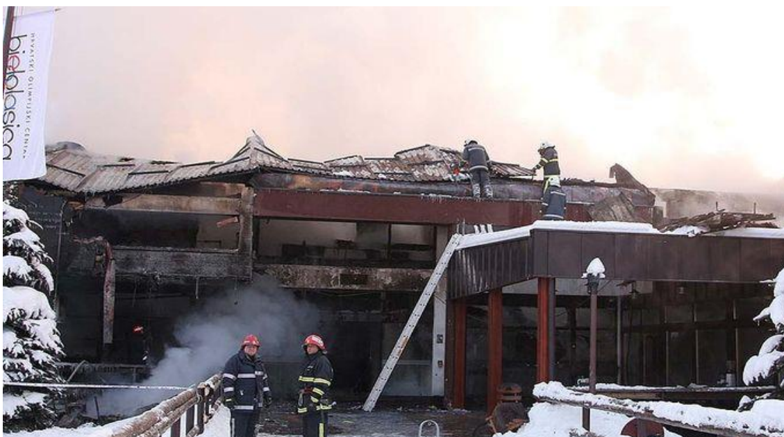
Sl.15. HOC Bjelolasica izgorjela zbog pregrijanog dimnjaka [15]
