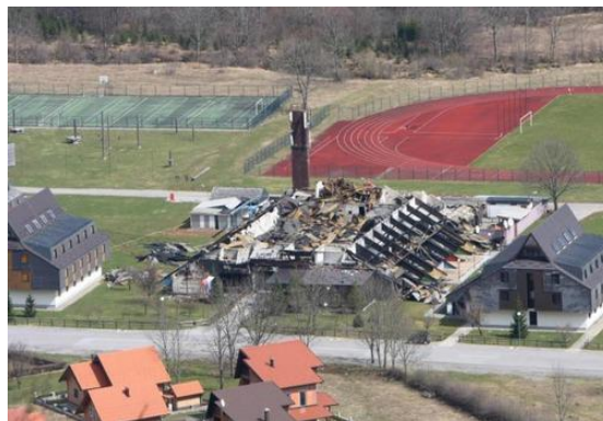
Sl.14. Kotlovnica i dimnjak [15]
