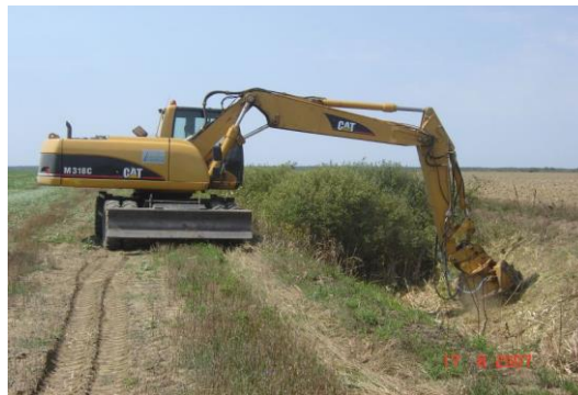
Slika 6. Tarupiranje kanala (Izvor: www.vodoprivredavinkovci.com )
