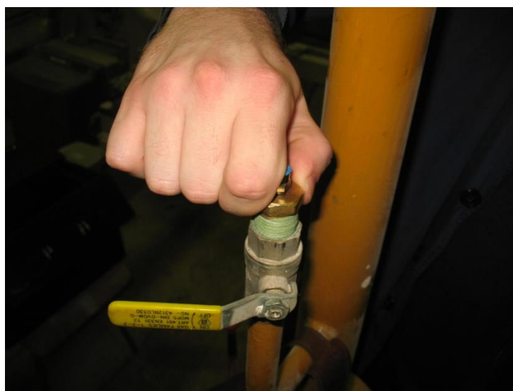
Slika 19. - Pritezanje priključka rukom
