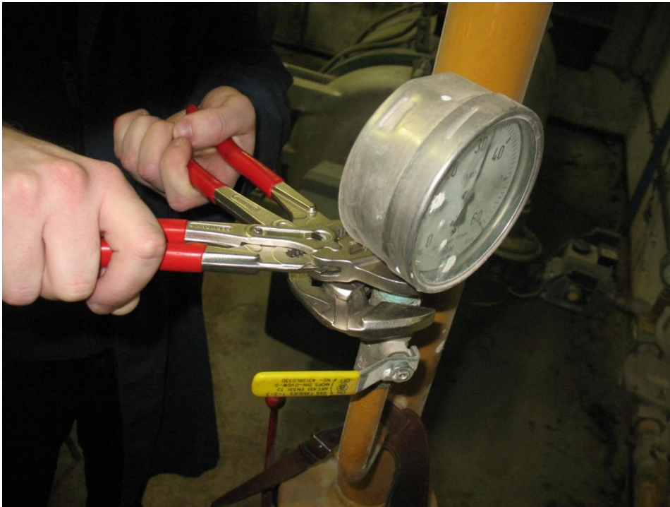
Slika 16. - Odvijanje manometra pomoću kliješta
