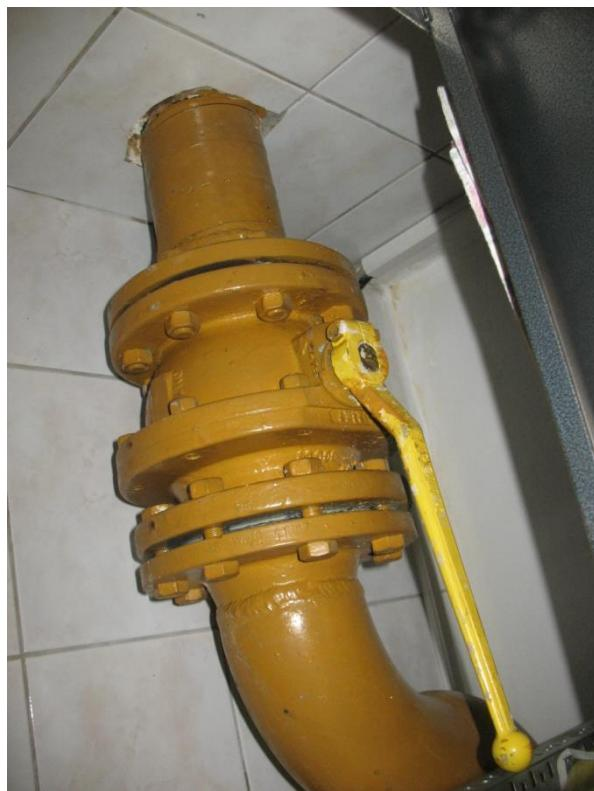
*Slika 13. - Glavni zaporni ventil plinske instalacije*
