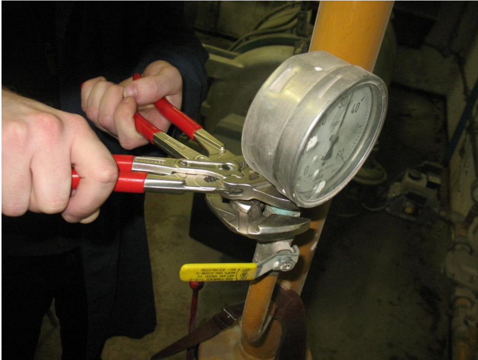
Slika 16. - Odvijanje manometra pomoću kliješta
