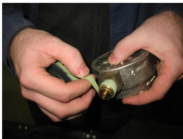
*Slika 25. - Namatanje teflonske trake na navoj manometra*
