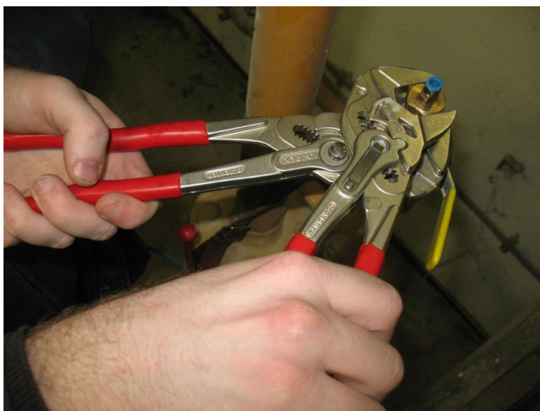
Slika 24. - Skidanje priključnog dijela sa instalacije
