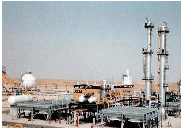
*Slika 2. - Postrojenje za izdvajanje LPG iz zemnog plina*
