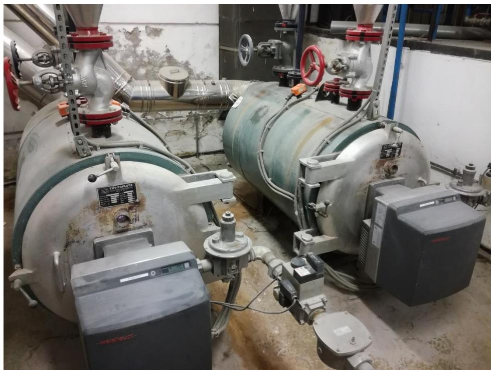
Slika 14. - Plinski kotlovi pojedinačne snage 200 kW
