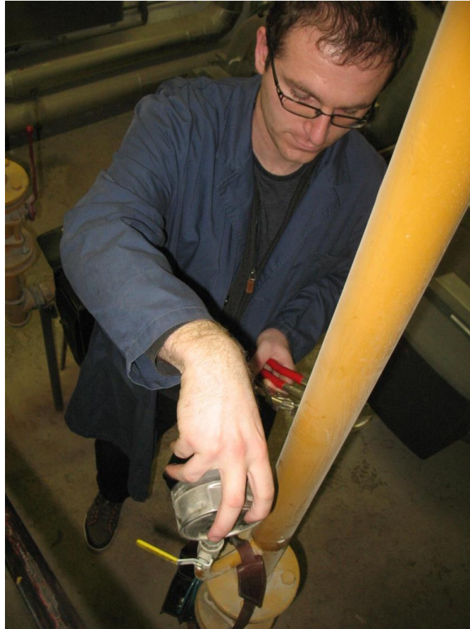
Slika 26. - Pritezanje manometra rukom
