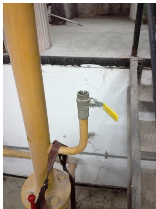
*Slika 17. - Priklučak za mjerni uređaj*
