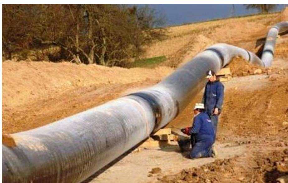
*Slika 6. - Zavarivanje magistralnog plinovoda*
