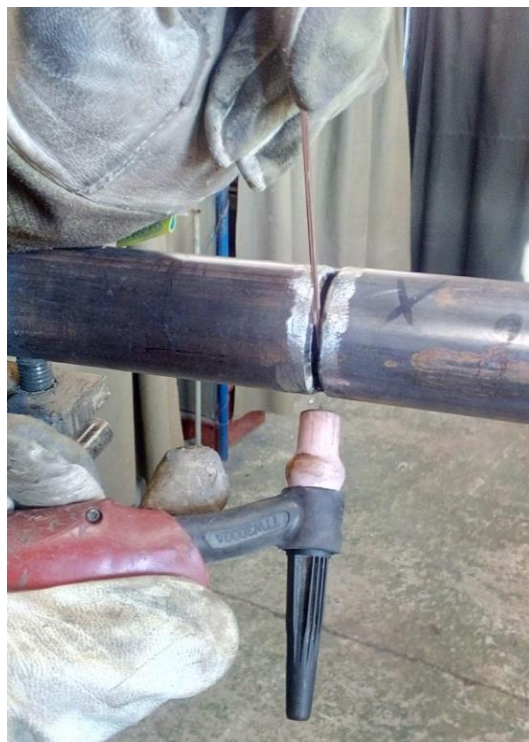
Slika 38. Namještanje elektrode i dodatnog materijala
