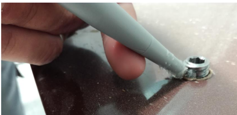
Slika 69. Silikoniranje vanjskog navoja trio matice
