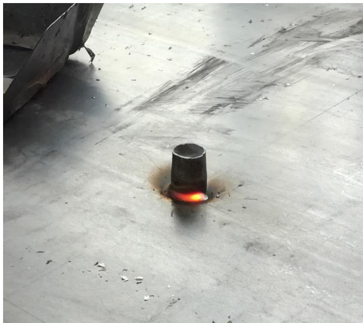
Slika 75. Cijev u trenucima nakon zavarivanja
