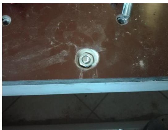
Slika 90. Improvizirani vijak M10x130 ugrađen u vakuum stol
