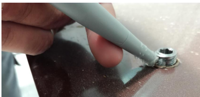
Slika 69. Silikoniranje vanjskog navoja trio matice
