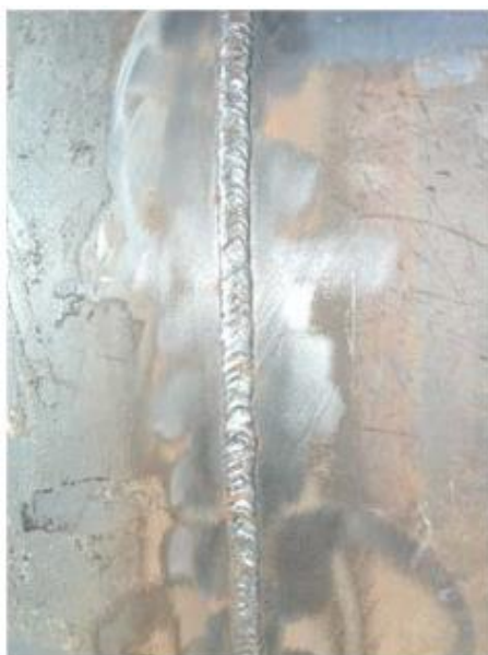
Slika 38. Izgled zavarenog spoja izveden silaznom REL tehnikom zavarivanja uz korištenje celulozne elektrode [21]
