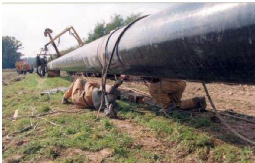
**Slika 35. Zavarivanje cjevovoda celulozno obloženom elektrodom [21]**
