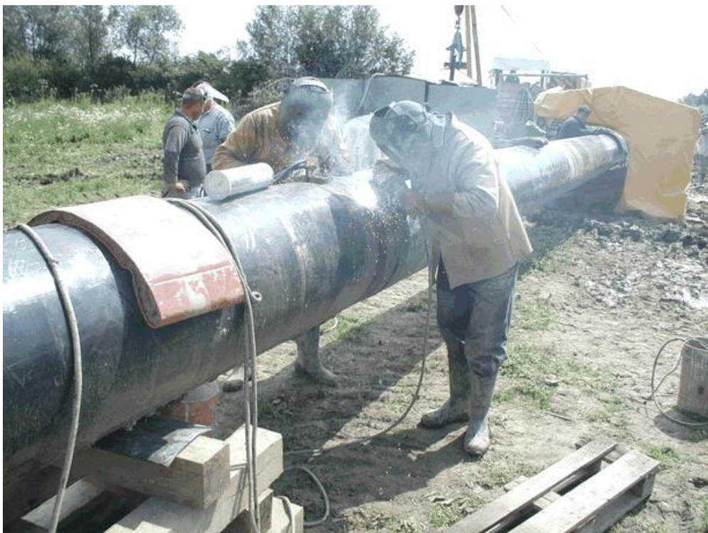
Slika 5. REL zavarivanje cjevovoda [4]
