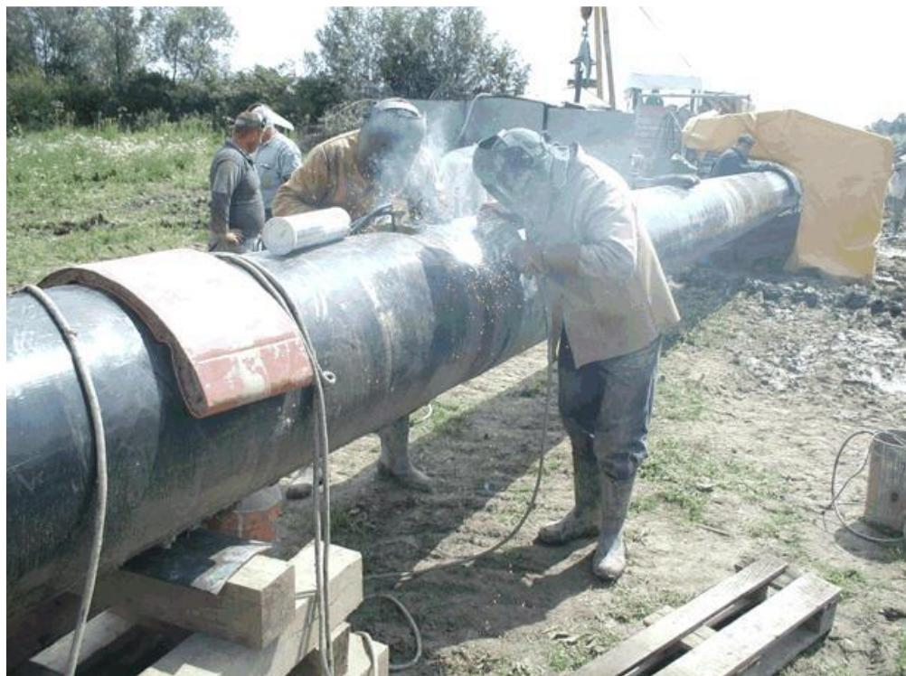
Slika 5. REL zavarivanje cjevovoda [4]
