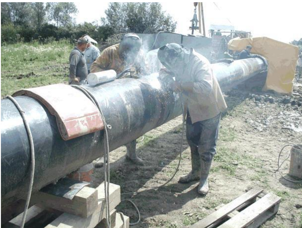
Slika 5. REL zavarivanje cjevovoda [4]
