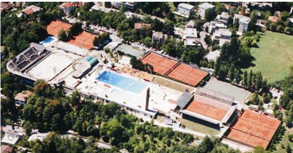
Slika 4: Bazen u sklopu klizališta
