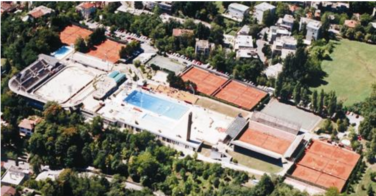
Slika 4: Bazen u sklopu klizališta
