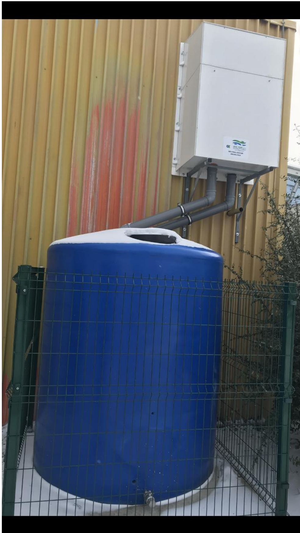
Slika 15: Neutralizator amonijaka
