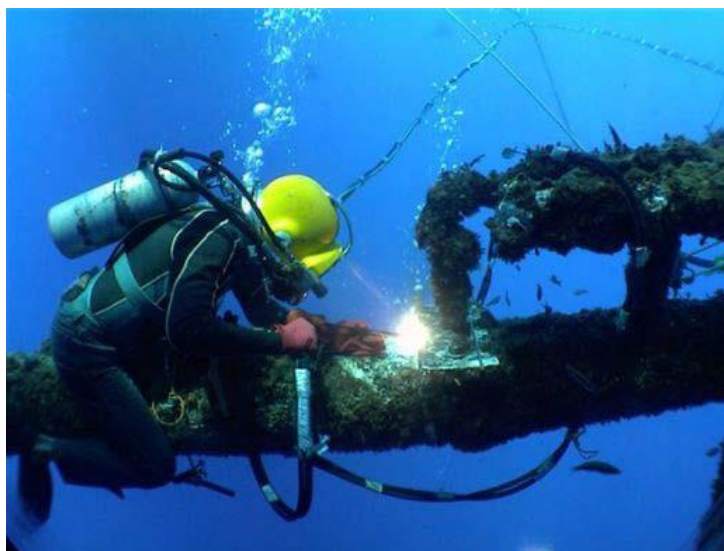
Slika 4. Mokro podvodno zavarivanje[4]
