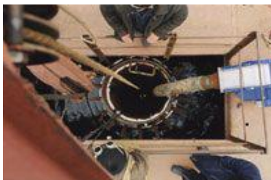
Slika 7. Atmosfersko podvodno zavarivanje[30]
