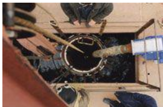
Slika 7. Atmosfersko podvodno zavarivanje[30]
